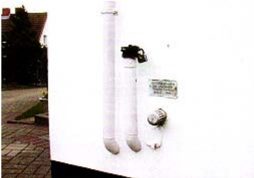
**Bild 28: Befüllstutzen und Grenzwertgeberanschluss an einem häuslichen Heizöltank, links die Entlüftung.**
