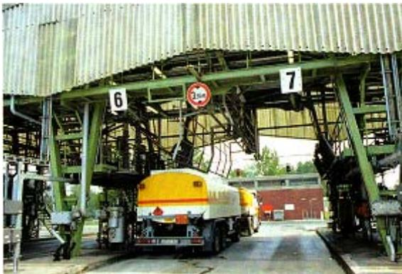
**Bild 21:** Übliche Füllbühne für Top-Loading, mit der das Tankfahrzeug sowohl von der rechten als auch der linken Fahrzeugseite erreicht werden kann.
