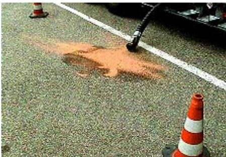
**Bild 35:** Aufnehmen von Produkt mit Ölbindemittel.
